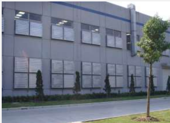
Industrial Factory Ventilation 工业工程通风
